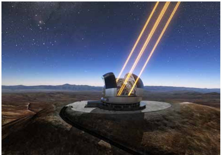
Representación artística del Extremely Large Telescope en funcionamiento en Cerro Armazones, en el norte de Chile. El telescopio utiliza rayos láser para crear estrellas artificiales en la atmósfera. Crédito: ESO/L. Calçada
